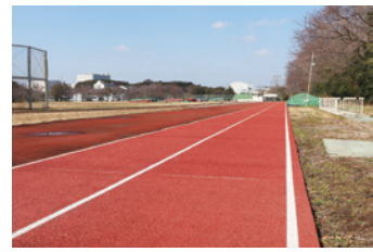
完成した陸上競技場
